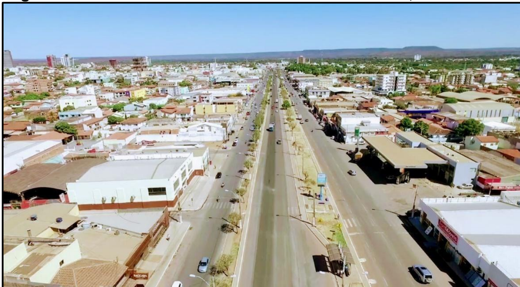
Figura 3 - Vista Parcial de Trecho Urbano da BR-242, em Barreiras.
